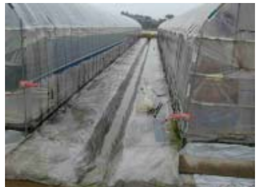
写真1. ハウス外の排水対策の様子
