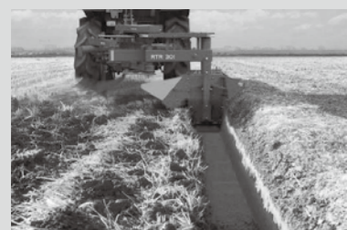
トレンチャーによる額縁排水溝の設置
