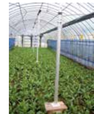
突き上げ支柱を設置することで耐雪力は向上します。
